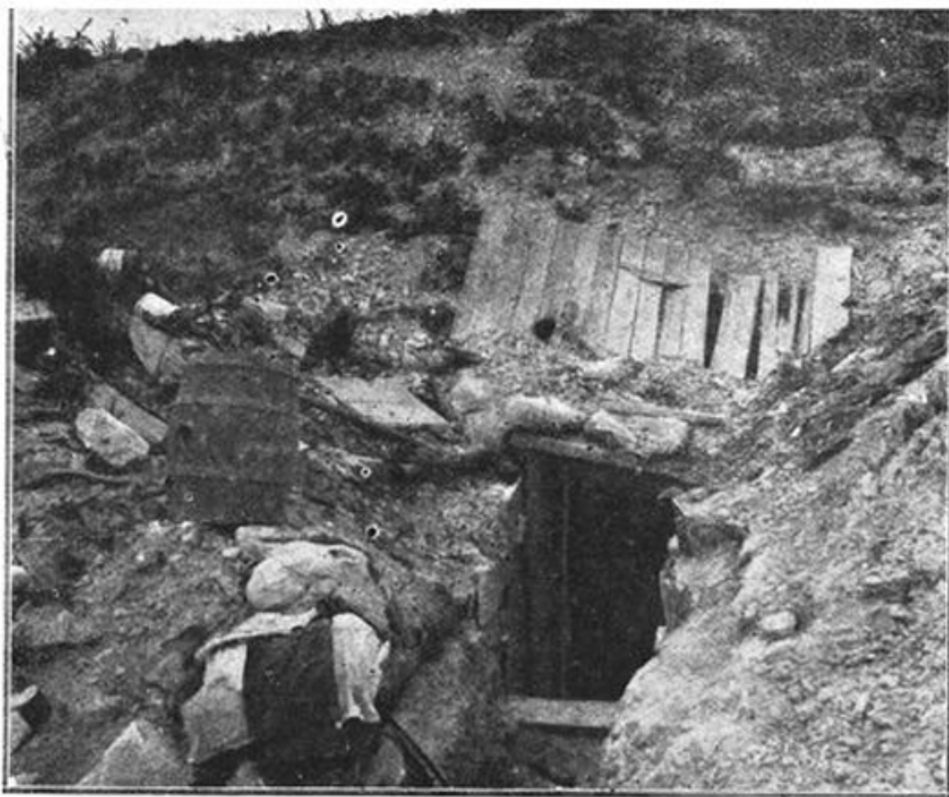
Entrée d'un abri allemand souterrain, dans Blanche-Voye.
