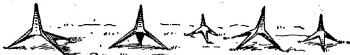
Chausse-trapes faites d'un simple morceau de fer découpé à l'emporte-pièce, et dont les branches sont repliées de telle façon que, jetées à terre, elles présentent toujours verticalement une de leurs pointes.
