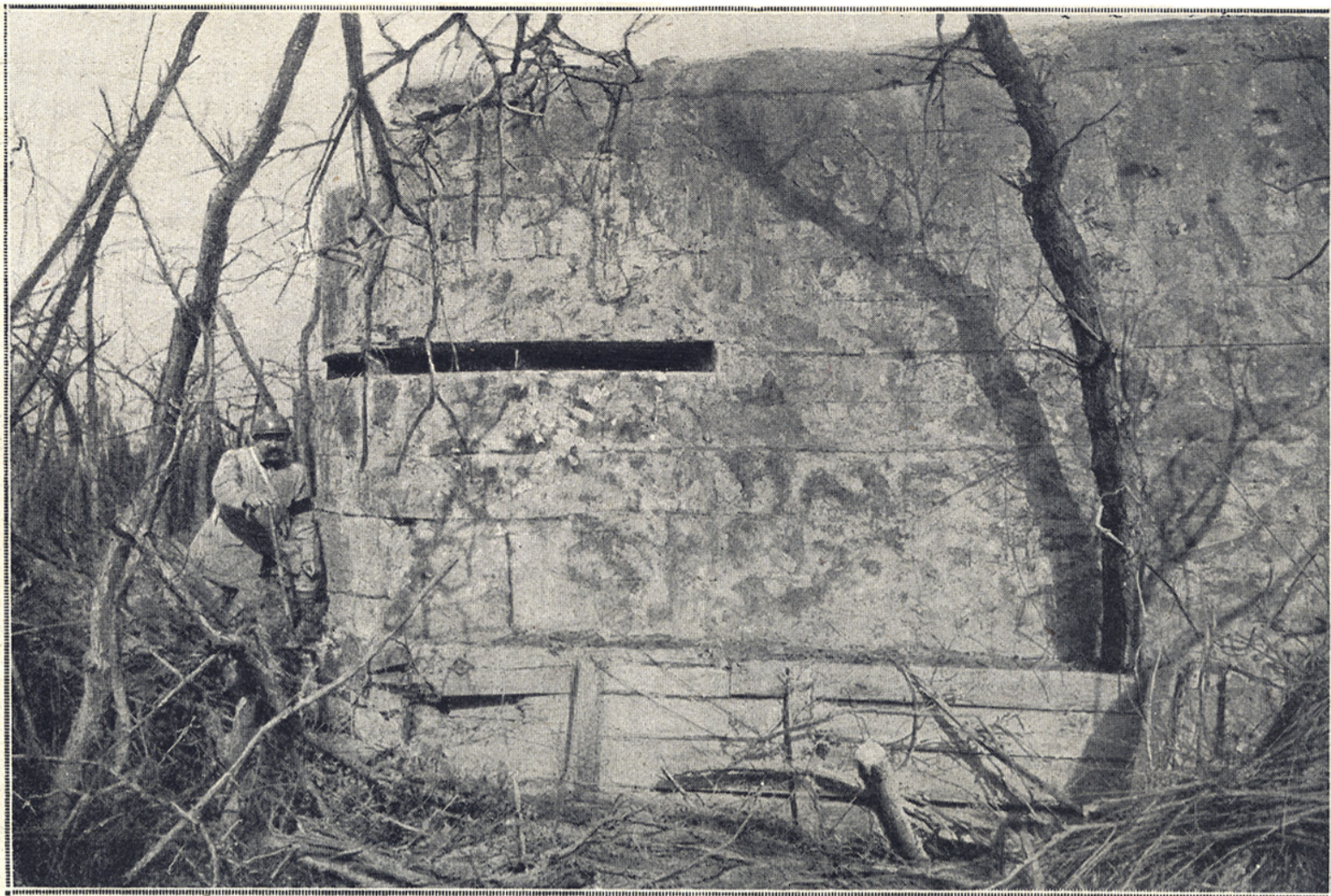
Abri moderne allemand en béton armé avec créneau de mitrailleuse à grand champ horizontal. (Bois des Baguettes, au N.-E. de la Maison du Passeur.)
