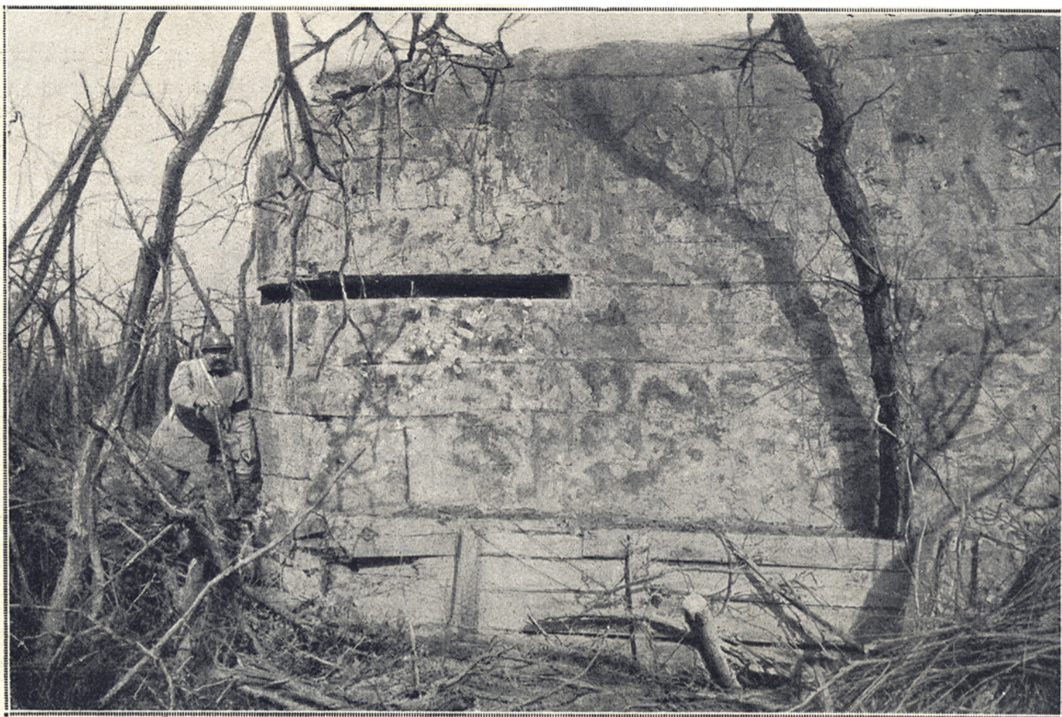
Abri moderne allemand en béton armé avec créneau de mitrailleuse à grand champ horizontal. (Bois des Baguettes, au N.-E. de la Maison du Passeur.)
